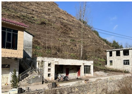
原村卫生室（60 m 2 ，4 间房间）
